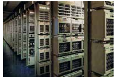
K50 relaisgroepen in relaisruimte Bron Siemens
