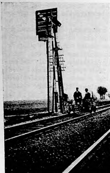
Afb. 13. Automatische voorseinpaal vóór de in-dienst-stelling en motorlorrie.
