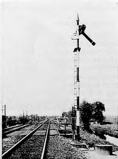
Afb. 18. Automatische voorseinpaal in „langzaam rijden”-stand.
