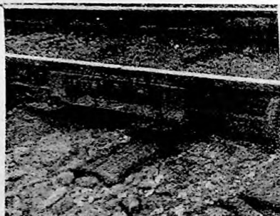
Afb. 10. Isoleerende lasch met oude wijze van aansluitingen aan den spoorstaaf (dubbel uitgevoerd).
