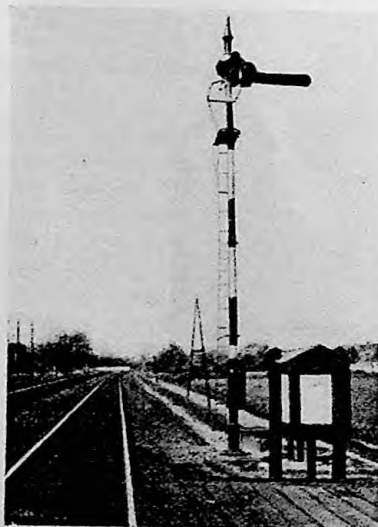
Afb. 20. Automatische hoofdseinpaal in „onveiligen” stand (met telefoon T)
