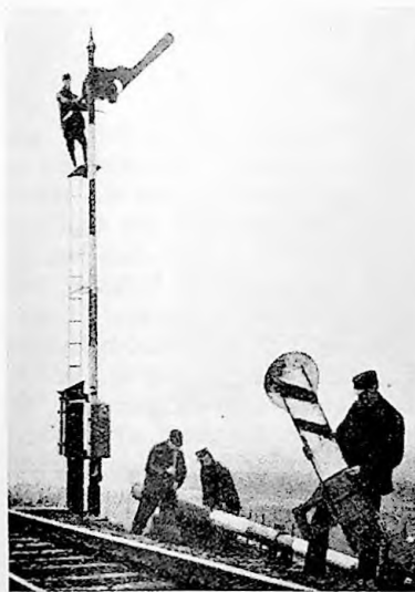
Afb. 17. Automatische blokseinpaal in dienst, oude blokseinpaal gestreken.
